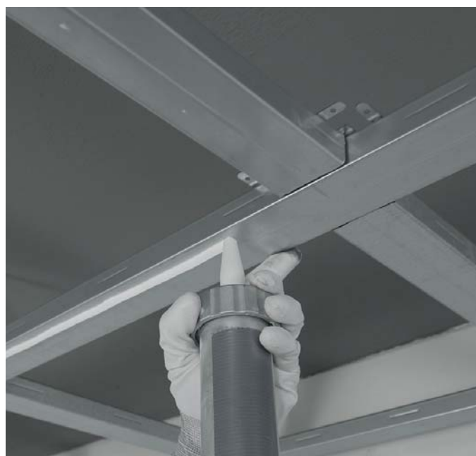
Nanášanie lepidla pištoľou na lepidlo
