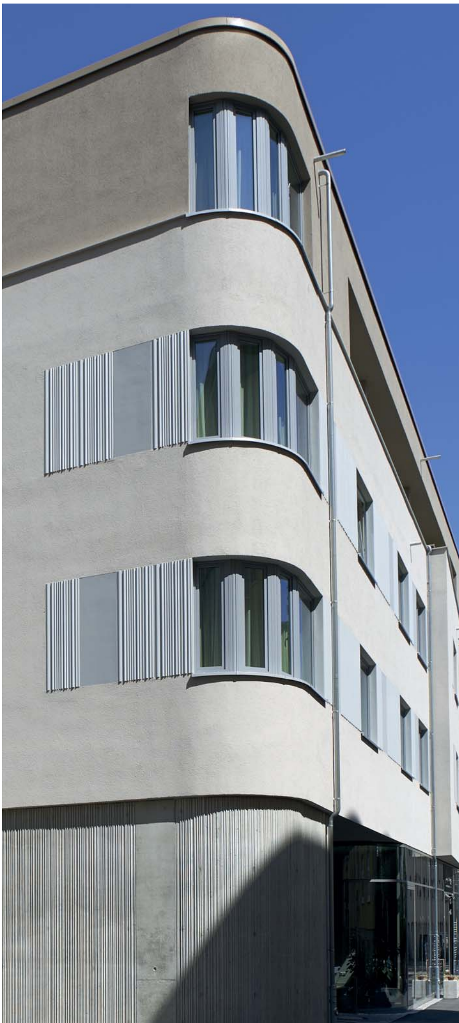
Novostavba hotela „Zur Noll“, Jena, DE Architekti: Sabine Walther, Jena, DE Realizácia: Neubauer Maler und Fußboden GmbH, Bad Berka, DE Riešenia od Sto: Zatepľovací systém StoTherm Classic®, fasádne prvky StoDeco, predsadený, odvetrávaný fasádny systém s omietkou StoVentec R Foto: Christian Günther, Lipsko
