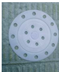
Povrchová montáž kotiev s roznášacím tanierikom Ø 90 mm na dvojvrstvovej minerálnej doske.
