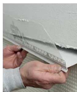
Vloženie soklového profilu medzi izolanty
