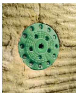
Povrchová montáž do minerálnej izolácie
