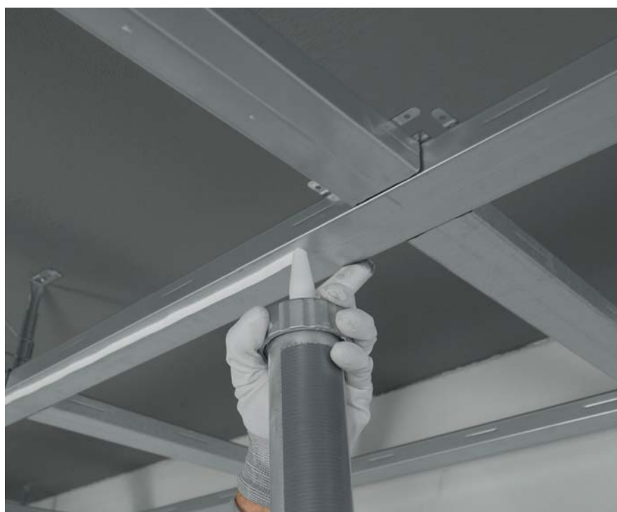
Nanášanie lepidla pištoľou na lepidlo
